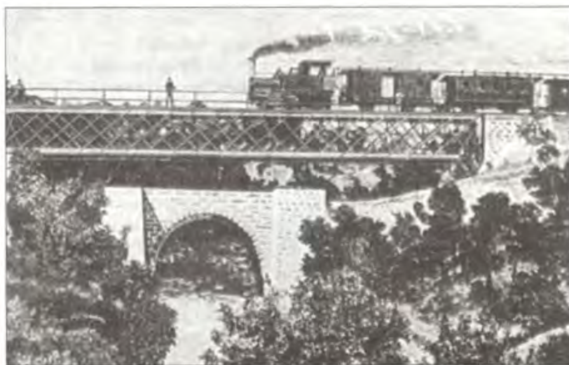
‘Αμαξοστοιχία της διαδρομής Πειραιώς–Αθηνών–Κορίνθου’ διέρχεται γέφυρα μεταξύ Έλευσίνας και Μεγάρων λίγο μετά τη λειτουργία της γραμμής τόν ‘Απρίλιο του 1885.
